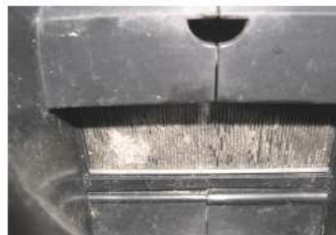
Achterzijde van een vervuilde filter
